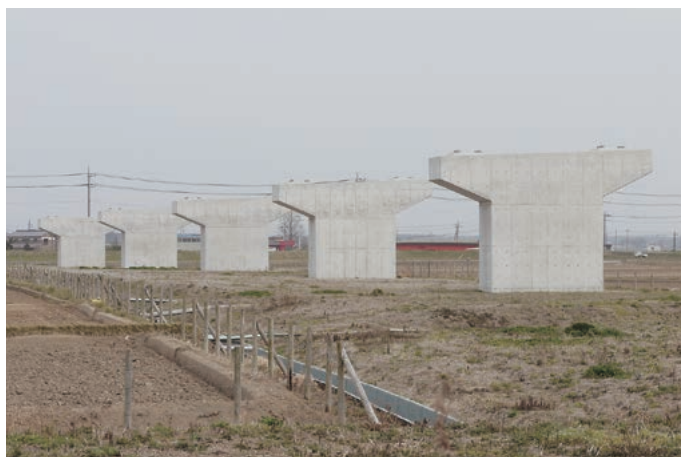
整備が進む首都圏中央連絡自動車道
