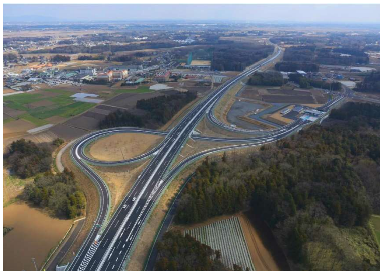
▲圏央道坂東インターチェンジ航空写真（国土交通省撮影）
