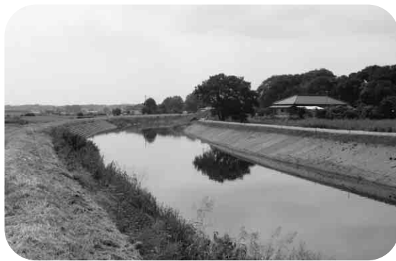
改修工事が進められている西仁連川の一部決壊箇所
