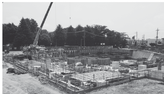
▲新庁舎建設工事
