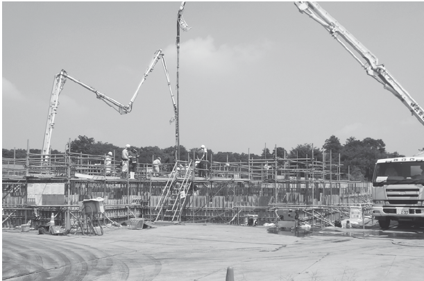
坂東インター工業団地配水場建設工事
