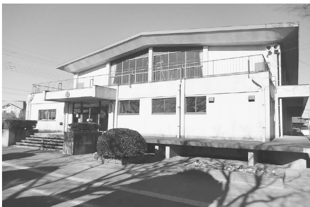
生子菅小学校体育館
