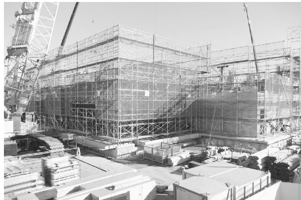
新庁舎建設工事の様子
