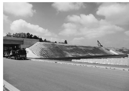
工事が進められている 坂東インター周辺
