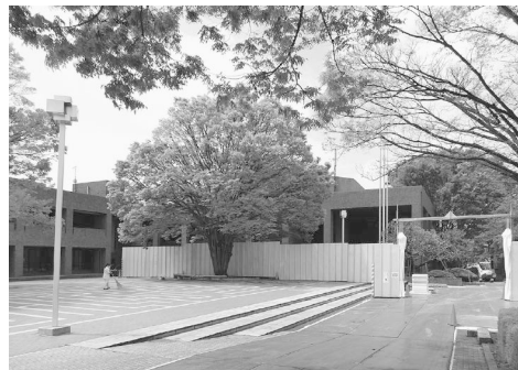
工事予定の 総合体育館
