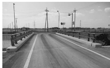
架け替えが行われた天神橋
