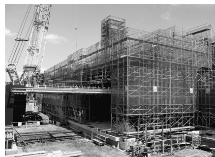
新庁舎建設工事
