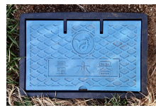
▲水道メーターボックス
