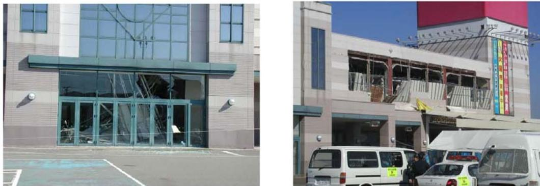
図3-4 天井材・外壁が崩落したRC造大型店舗（中越地震）
