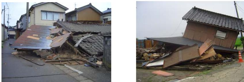
図3-2 木造住宅の倒壊（新潟県中越沖地震の被災例）
