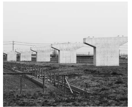
▲整備が進められる圏央道
