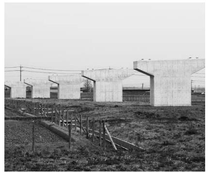
▲整備が進められる圏央道
