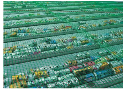
▲市役所岩井仮設庁舎には、節電対策として、屋根の上にたくさんの空缶が並べられました。
