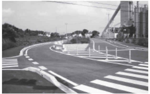
▲一部供用開始する国道354号岩井バイパス
