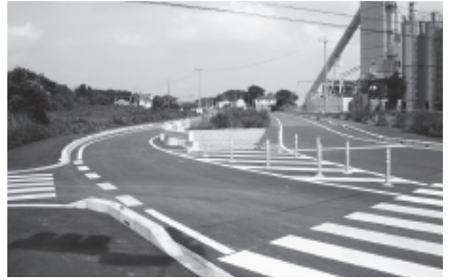
▲一部供用開始する国道354号岩井バイパス
