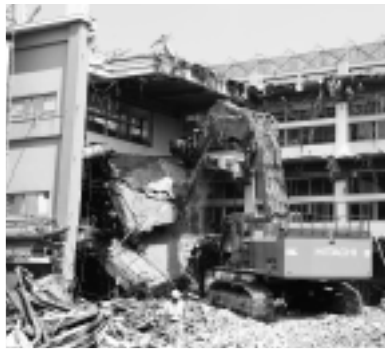
▲解体が進む岩井庁舎
