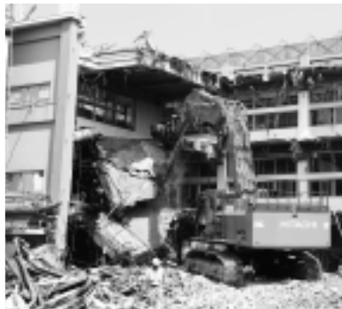
▲解体が進む岩井庁舎
