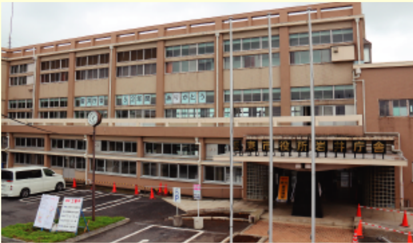
▲東日本大震災で被害を受けた岩井庁舎の解体工事が始まりました。
