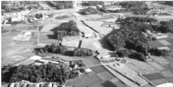
▲坂東IC 平成26年11月撮影(東日本高速道路(株)水戸工事事務所)
