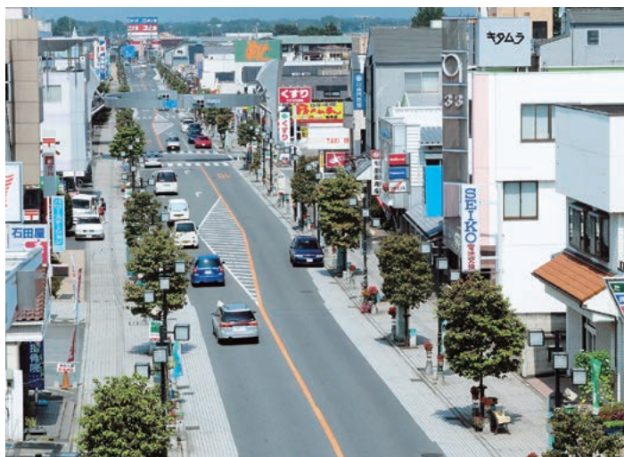
市街地における道路の整備
