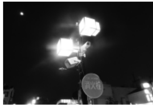
▲LED化した街路灯と設置した防犯灯
