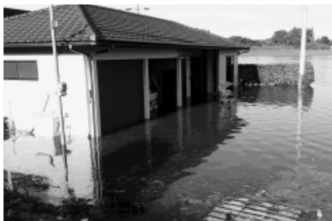
▲水が押し寄せた住宅(辺田地区)
