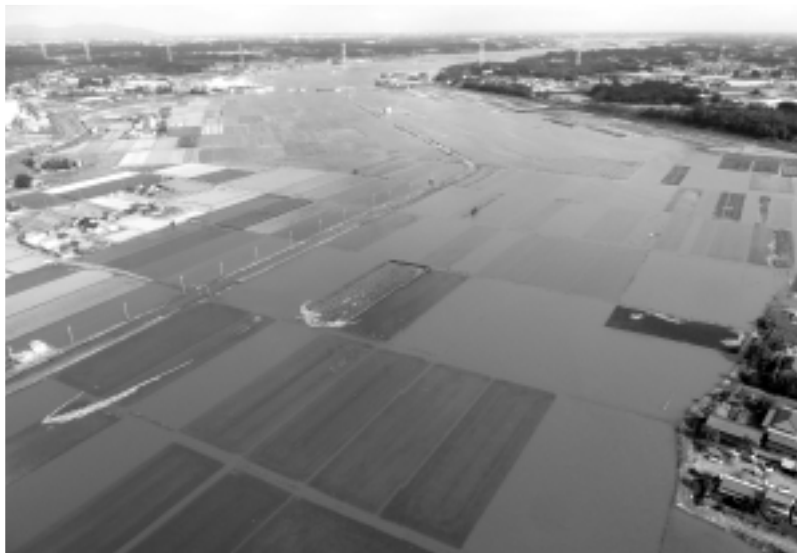
▲堤防の決壊などにより、一面冠水した南総土地改良区の圃場
