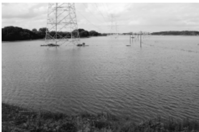
▲一面冠水した鵜戸沼土地改良区の圃場(内沼)
