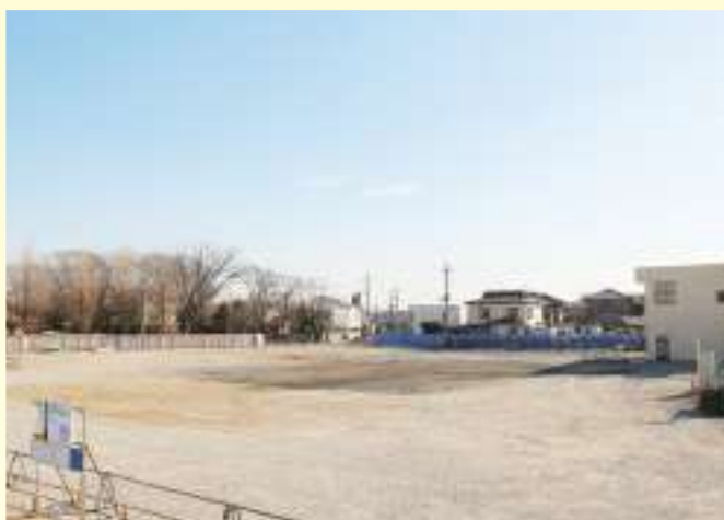
▲ 1 月 着工前の更地の状態。
