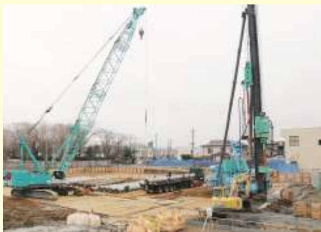
▲ 3 月 基礎杭 61 本の工事が始まりました。
