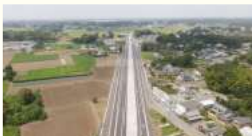
▲国道 354 号 岩井バイパス全線開通
