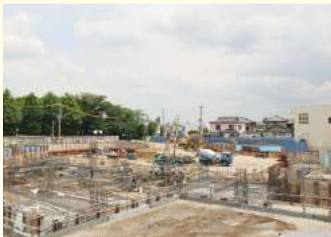
▲ 6 月 地下部分のコンクリート工事が始まりました。
