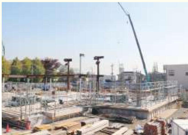
▲ 11 月 これから地上部分(1 階～5 階)の鉄骨工事、コンクリート工事などが始まります。
