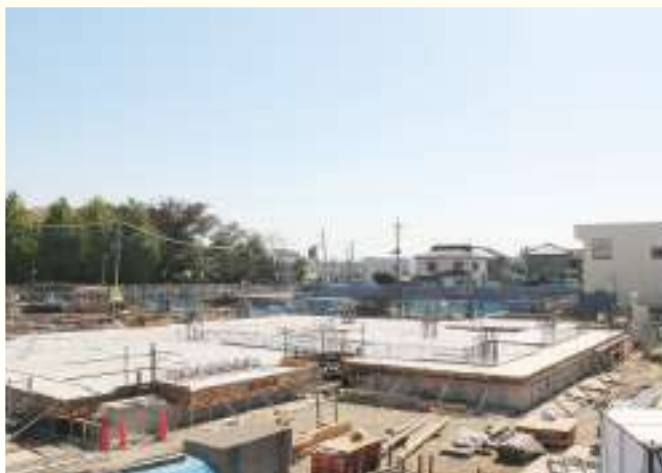
▲ 10 月 地下部分のコンクリート工事が終了し、1 階の床部分ができあがりしました。
