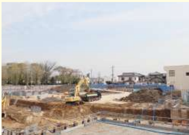
▲ 4 月 地下部分の掘削工事が始まりました。
