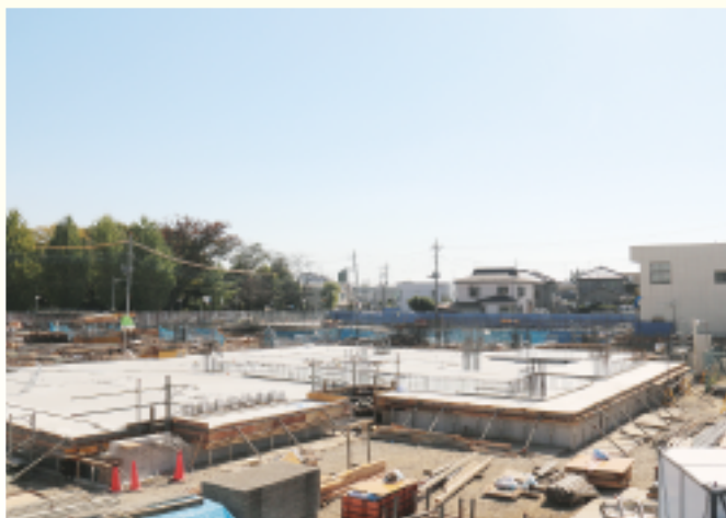
▲ 10 月 地下部分のコンクリート工事が終了し、1 階の床部分ができあがりました。
