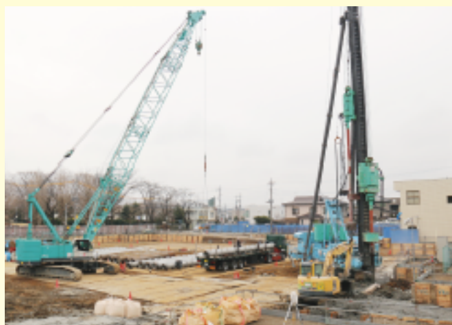
▲ 3 月 基礎杭 61 本の工事が始まりました。
