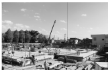
▲基礎完成(平成 25 年 10 月)
