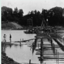
▲仮締切くい打ち状況
