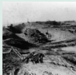
▲堤防復旧工事 中川村(現・坂東市)
