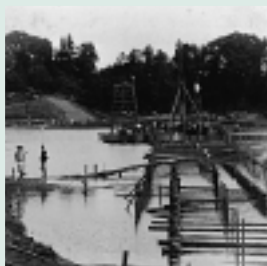
▲仮締切くい打ち状況
