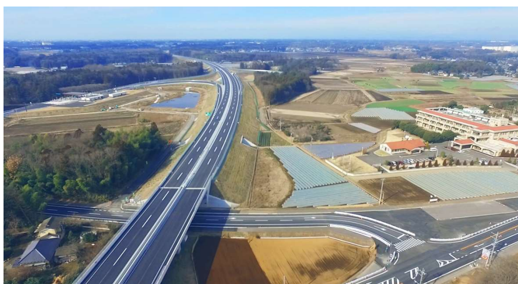
▲圏央道坂東インターチェンジ上空写真（H29.3 撮影）
