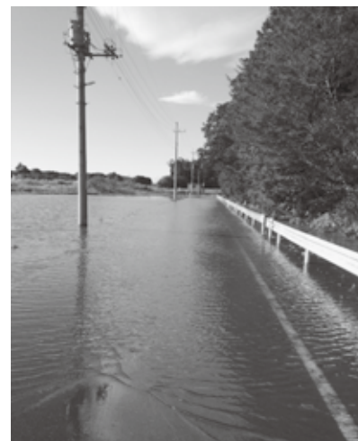
▲道路冠水による通行止め箇所（生子地内）
