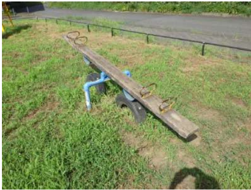
⑦ 遊具の劣化
