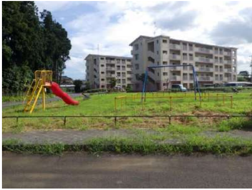
⑤ 遊具の劣化
