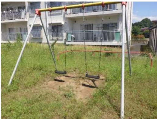
⑨ 塗装の劣化（遊具）
