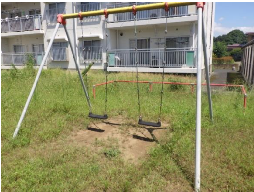
⑨ 塗装の劣化 (遊具)
