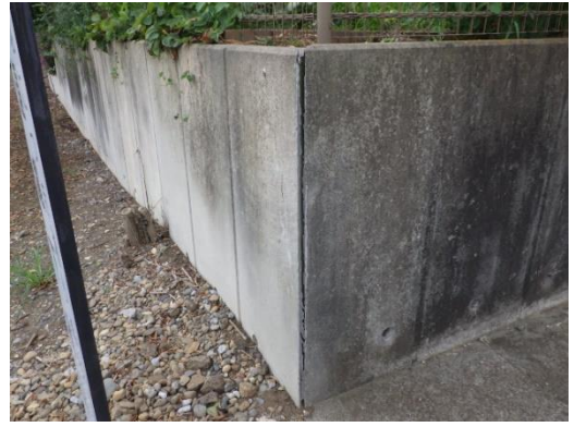
⑥ 土留めの際間
