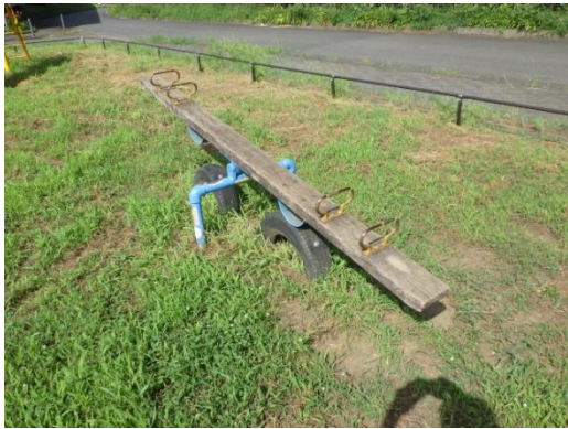
⑦ 遊具の劣化
