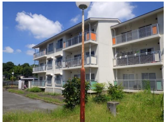
⑩ 鉄部の錆 (外灯)
