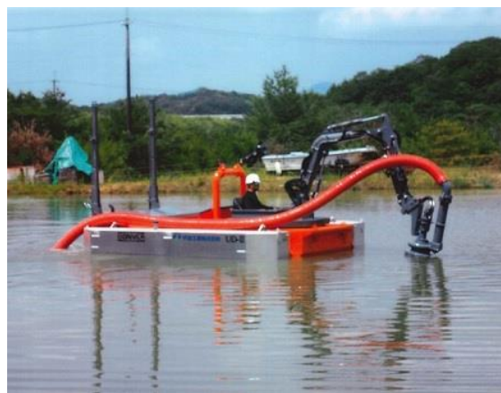
水面で浚渫作業を行うコンバー
