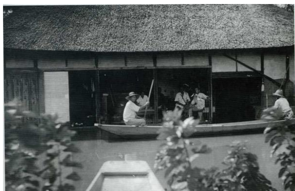
【出典：飯沼の洪水で冠水した家 坂東市ホームページ 資料館】
