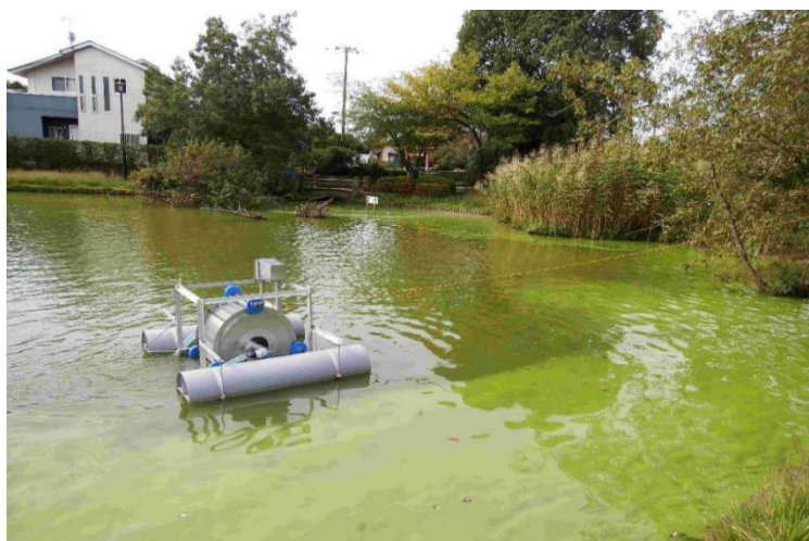
水戸市大塚池での施工状況 アオコ除去装置「アルデア」
