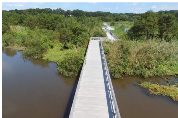
北側(あすなろの里)から エントリーする菅生沼ふれあい橋
