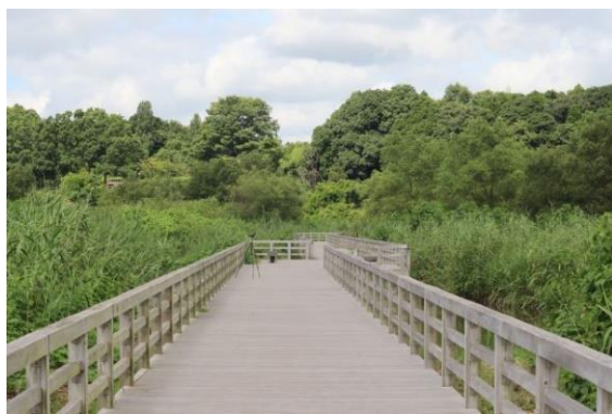
南側(県立自然博物館)から エントリーする菅生沼ふれあい橋
