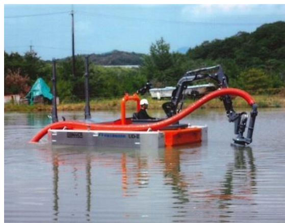
水面で浚渫作業を行うコンバー
