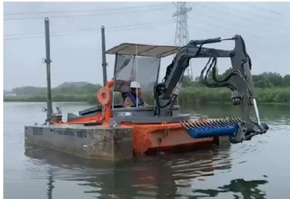
アームにレーキを取り付け作業するコンバー
