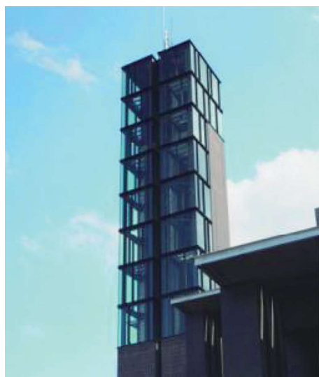
坂東市役所 先進エコ庁舎
