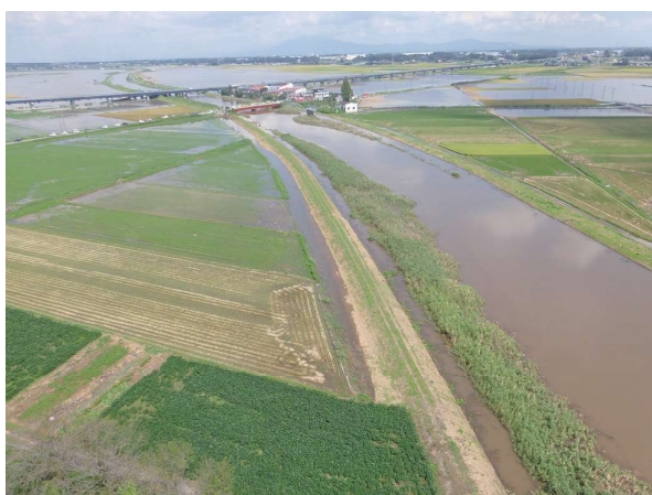
豪雨による河川の氾濫
