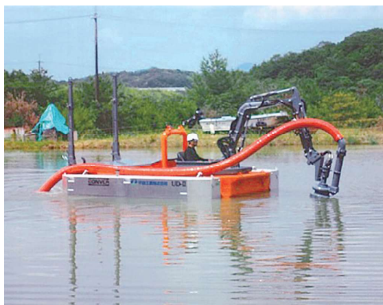
水面で浚渫作業を行うコンバー
