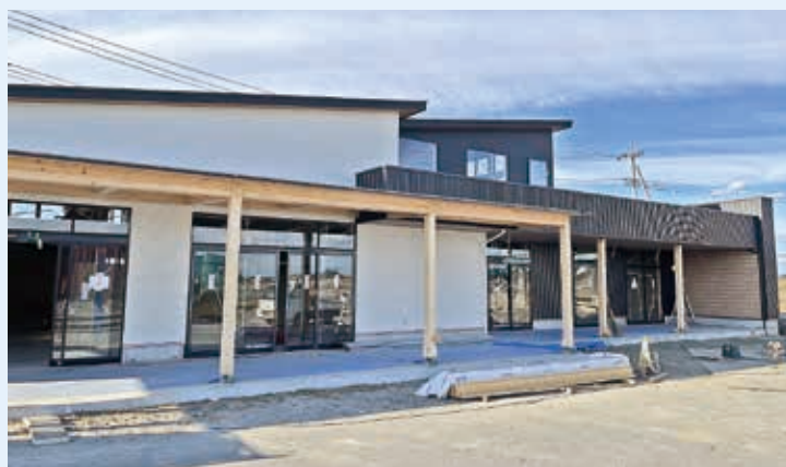
▲産業経済交流施設 建設中の状況
