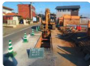
下水道工事の状況
