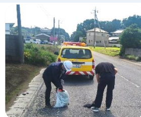
道路パトロール補修状況
