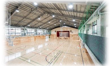
各学校体育館の整備
