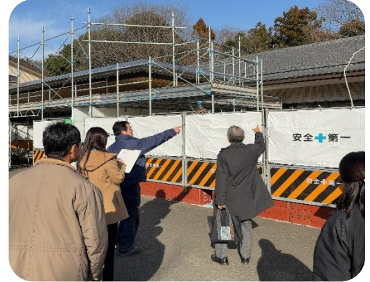
工事監査の様子
