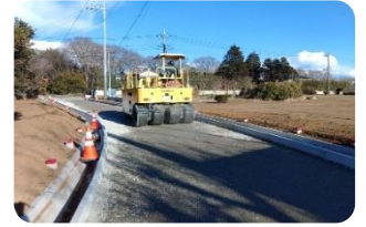
道路改良工事
