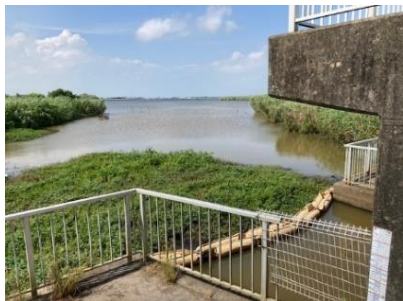
①侵入防止フェンス
